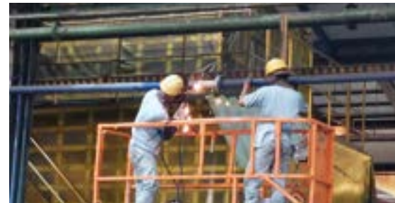
設備故障維修
