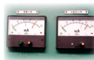
熔爐線圈冷卻水水溫及漏電流的監測設備 ▲
